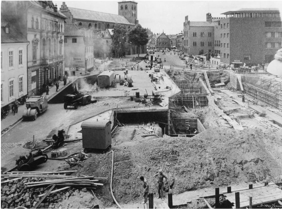
Figur 17 Albany Torv under anlæggelsen af P-kælderen i 1956. Foto Ditlev Jensen. Odense Bys Museer. CC-BY-SA.
