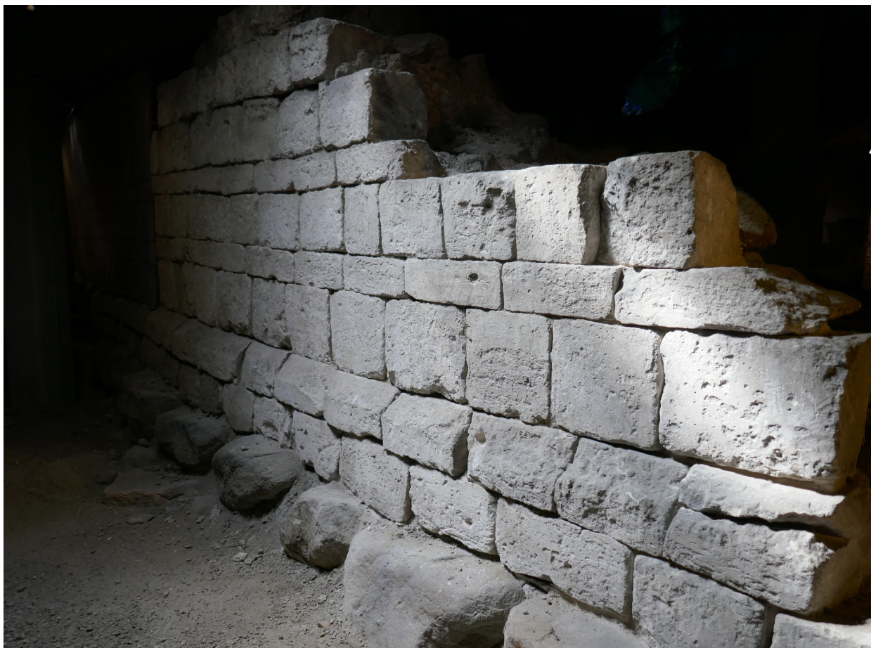
Fig. 9. Ypperligt kvalitet og sans for variation i murværket præger kridtstensmurens stenhuggerarbejde. Foto: Thomas Roland.
